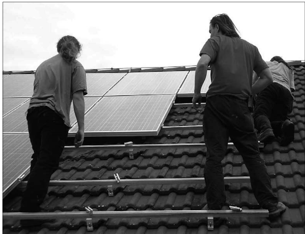
Beim Bau der Photovoltaikanlage im Magdeburger Stadtteil Salbke
