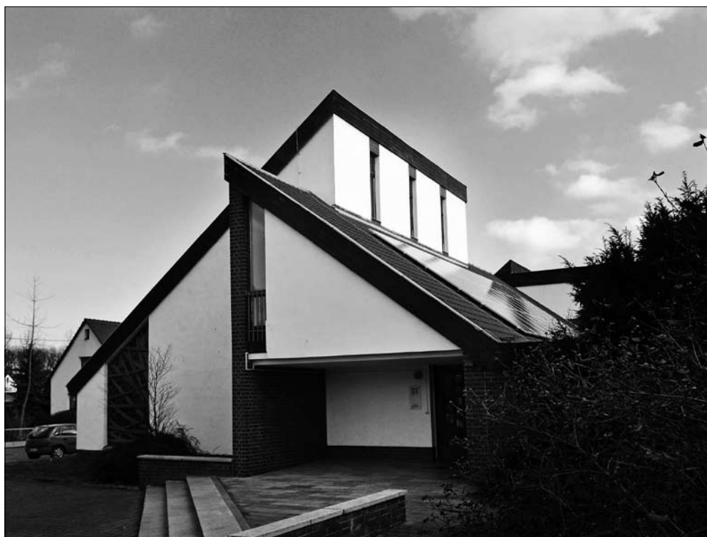
Photovoltaikanlage auf dem Gemeindezentrum des Kirchspiels Martini-Luther in Erfurt. Die Anlage, die seit Dezember 2008 in Betrieb ist, könnte vergleichsweise drei Haushalte mit Energie versorgen.
