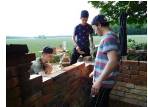
Wiederaufbau der Kirchhofmauer Vollenschier
